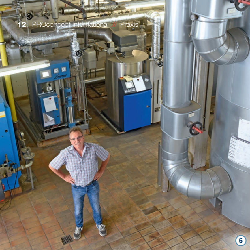
Der Leiter der Haustechnik Dirk Fell (6) überwacht die zwei Dampfgeneratoren für die Wäscherei.
