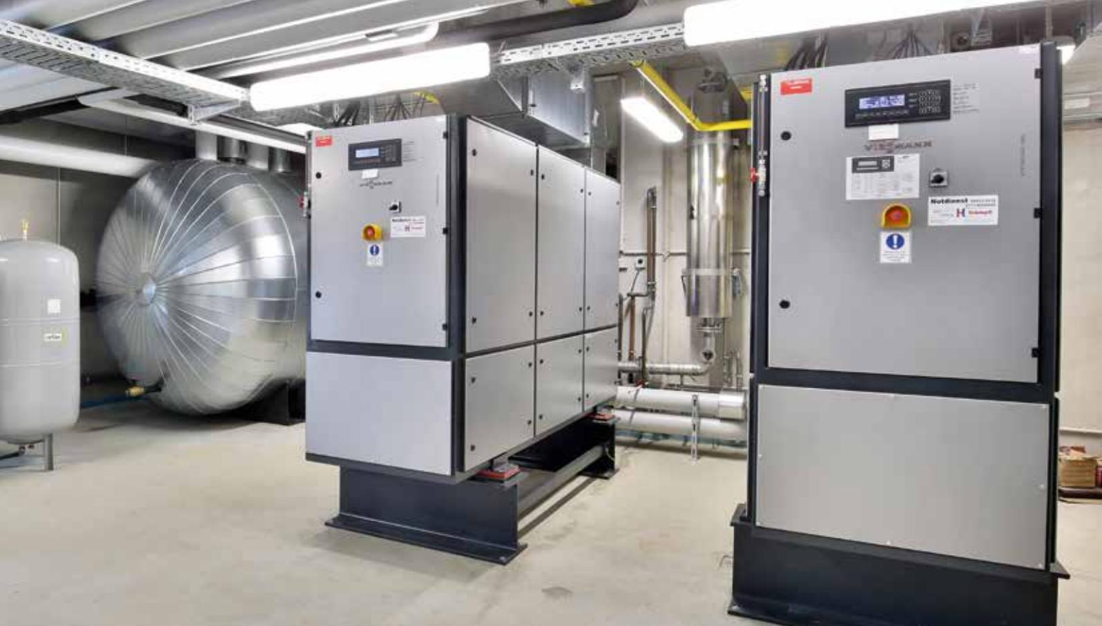
Zwei mit Gas betriebene Blockheizkraftwerke vom Typ Vitobloc 200 von Viessmann liefern den Strom und die Wärme für die Zentralwäscherei im BRK Senioren-Wohn- und Pflegeheim Plattling. Links davon steht der acht Meter lange Pufferspeicher, der 20.000 Liter Wasser fasst.
